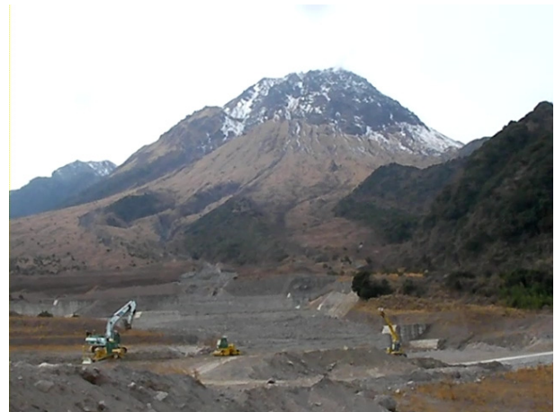
図4 雲仙普賢岳における無人化施工の様子
