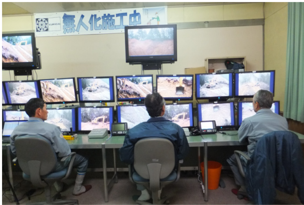
図5 現在の無人化施工の遠隔操作卓
