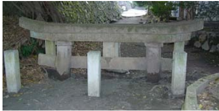
図2 黒髪集落の埋没した高さ 3 m の鳥居
