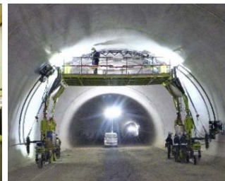
トンネル点検システム
