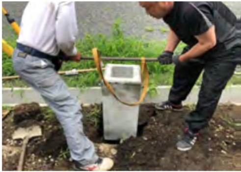
基礎ブロック設置
